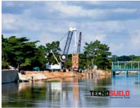
Protección de márgenes en el río Usumacinta
